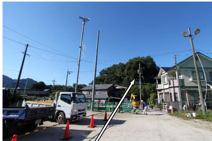
集会所入口角の電柱は移設
